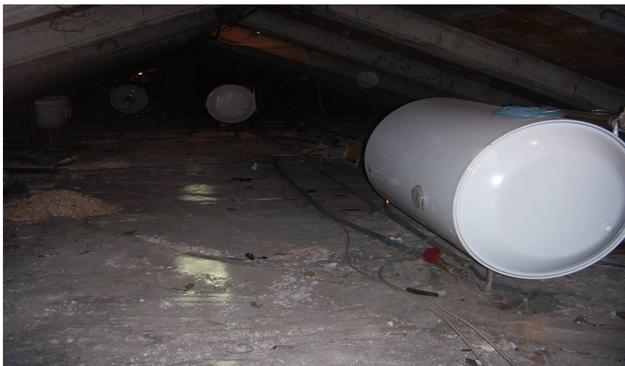
Foto 08- Boilers elettrici produzione acqua calda sanitaria
